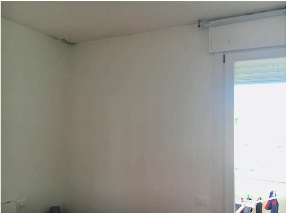
*Il dettaglio della congiunzione tra laterizio e solaio, realizzato in cemento, determina un "punto freddo" che misurato in fase di sopralluogo, differisce di parecchi gradi rispetto alla media accettabile della parete. (11/12 gradi puntuali rispetto ai 18/19 della media rilevata nell'intero appartamento).*
